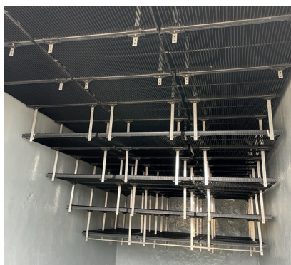
Remplacement corps d'échange type Clayettes par l'innovation COFINAIR by JACIR X-STREAM
