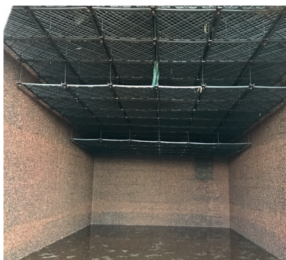
Remplacement corps d'échange type Clayettes par l'innovation COFINAIR by JACIR X-STREAM
