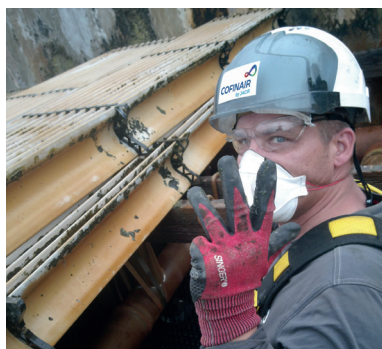
Remplacement distribution bois par acier inoxydable
