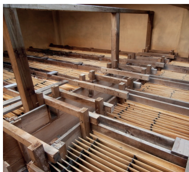
Remplacement distribution bois par acier inoxydable
