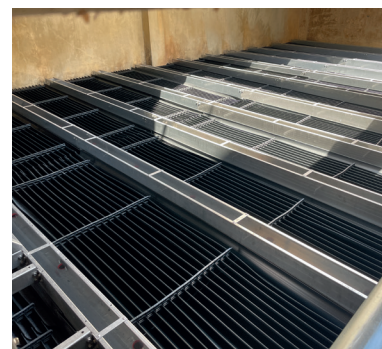
Remplacement distribution bois par acier inoxydable
