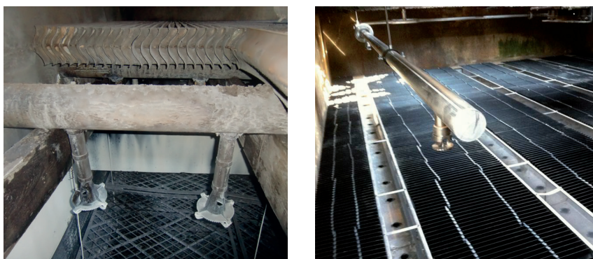
Remplacement de la distribution d'eau en tubes par des canaux à ciel ouvert pour faciliter la maintenance
