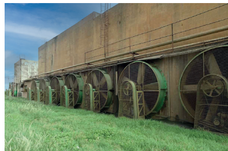
Rénovation tour béton
